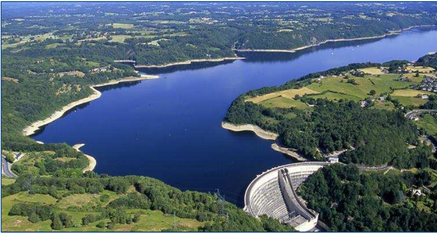
Barrage de Bort-les-Orgues (19)
