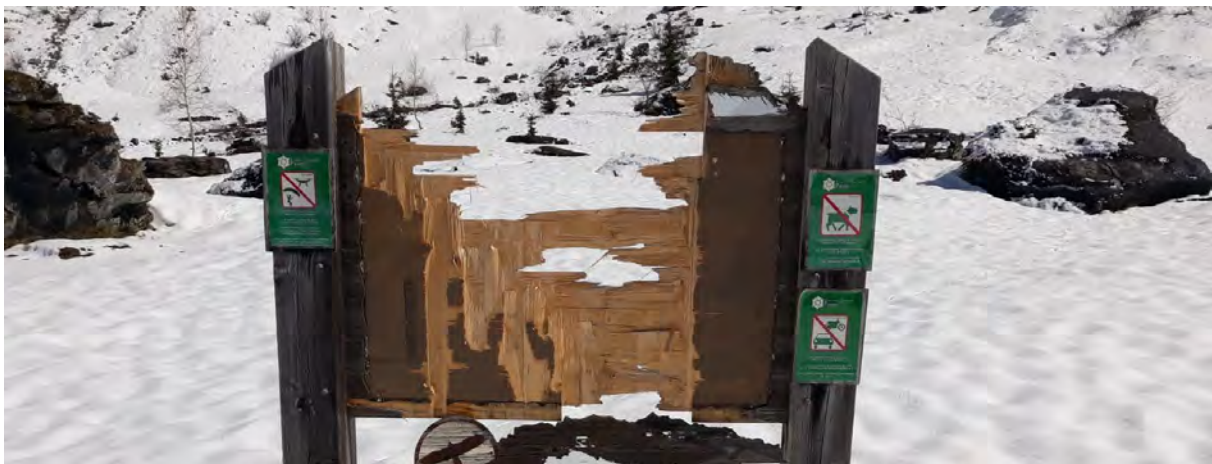
Dégât causé par le souffle d'une avalanche aux Ayères des Pierrières – Hiver 2020-2021
