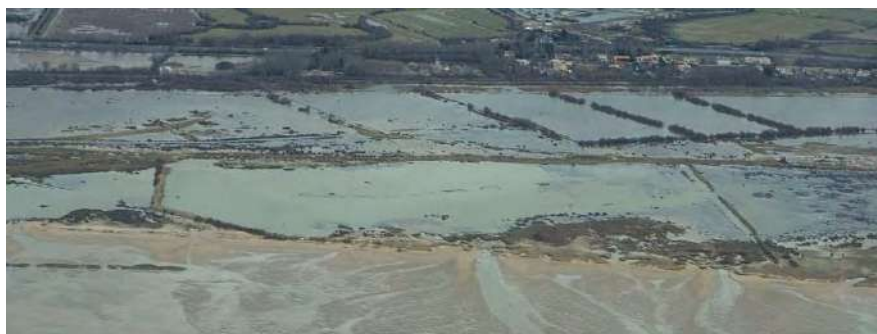
Photo 2 : Vue aérienne de la RNN du Marais d'Yves au lendemain de Xynthia - © Yann HERMIEU
