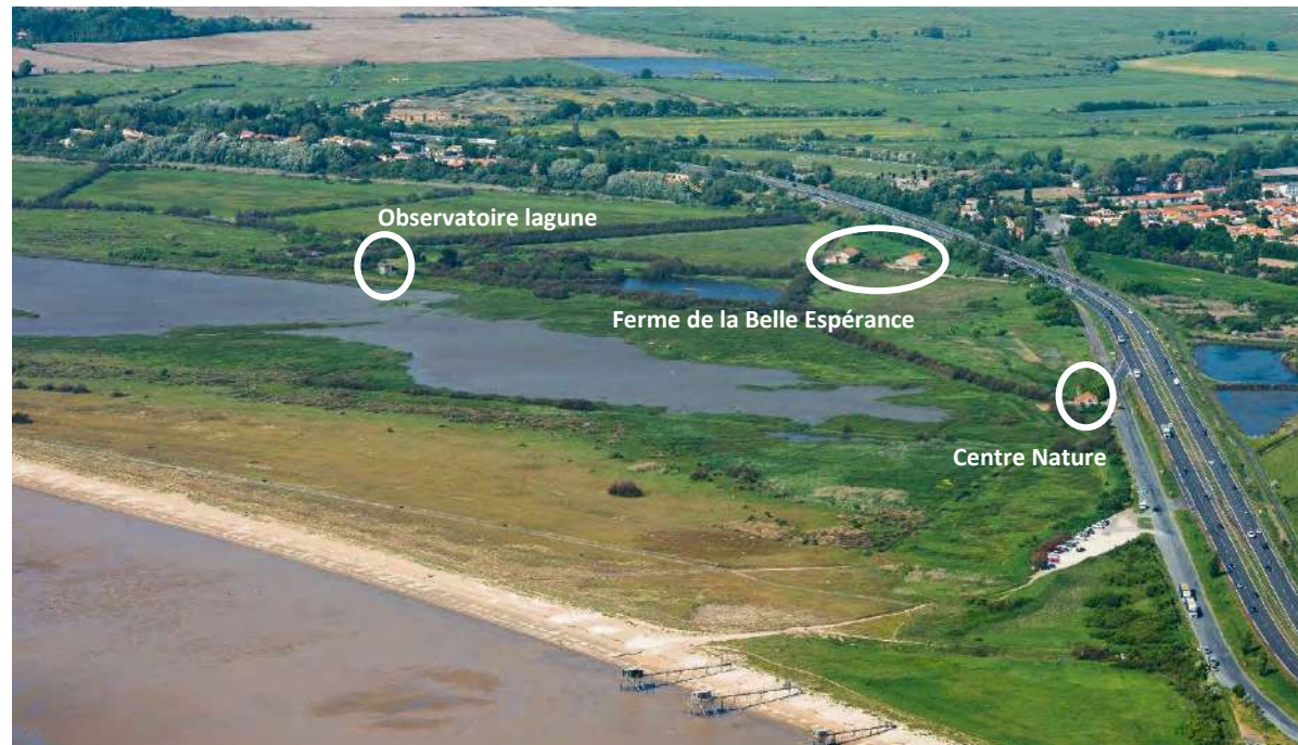
Photo 17 : Vue aérienne des bâtiments de gestion de la réserve naturelle - © David PACAUD
