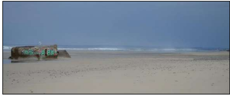
FIGURE 53 : BLOCKHAUS SUR LA PLAGE DE TRONOËN (©BOILLOT S., 2025)
