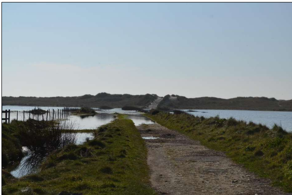
FIGURE 4 : CHEMIN ENNOYE AU NIVEAU DU CONCASSEUR (TREGUENNEC) (© S. BOILLOT)
